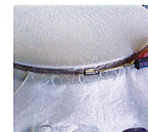
④金網押えリングを締付
